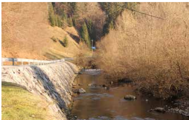
Poljanska Sora pri Kopsižarju - december 2019: urbana infrastruktura potrebuje zaščito pred negativnimi vplivi naraslih voda. Pol brežine je nedotaknjene, poskrbljeno je tako za varnost kot za vodni in obvodni živelj (foto: P. Valič).
