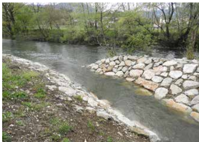
Nova ribja steza za lažjo prehodnost vodnih organizmov. V istem posegu pa obsežen del uničenega obrežja in večje pregrevanje reke (foto: P. Valič).
