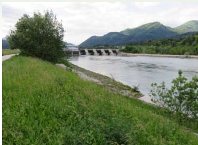
Pod hidroelektrarna Vrhovo se začne zgornja voda Boštanjkega jezera.
