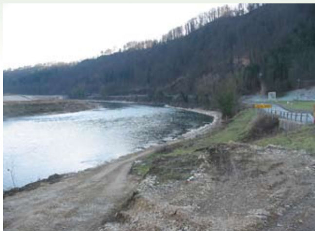
Sava na območju Orehovega leta 2003, ko so pričeli z gradnjo vodne infrastrukture.
