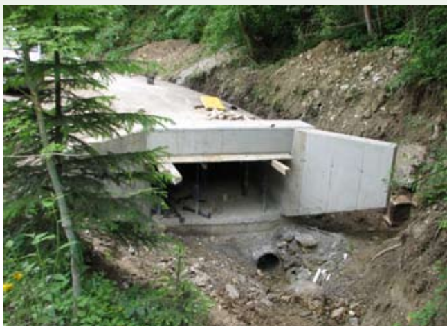
Gradnja naravnim procesom odtujenega cevne korita Apneniškega potoka.
