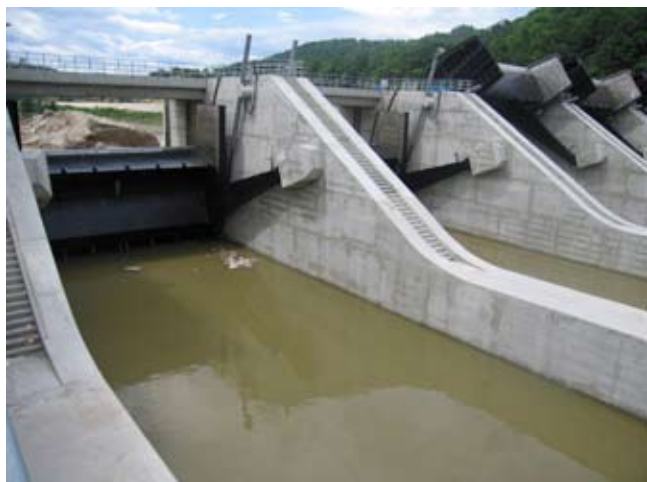
Leta 2005 je iz porušene gradbene jame pogledalo okostje hidroelektrarne v Boštanju.
