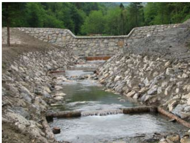
Na Podvinskem potoku je s protiprodno pregrado prekinjena selitvena pot reofilnih in oligoreofilnih vrst rib.
