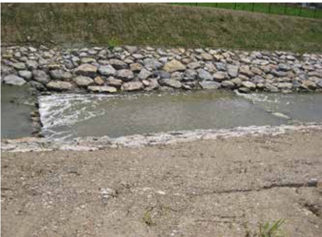
Pod kamnitim prelivnim pragom je voda poglobila podslapje in oblikovala obsežen tolmun, ki bo ribam omogočil preživetje v času sušnih pretokov.
