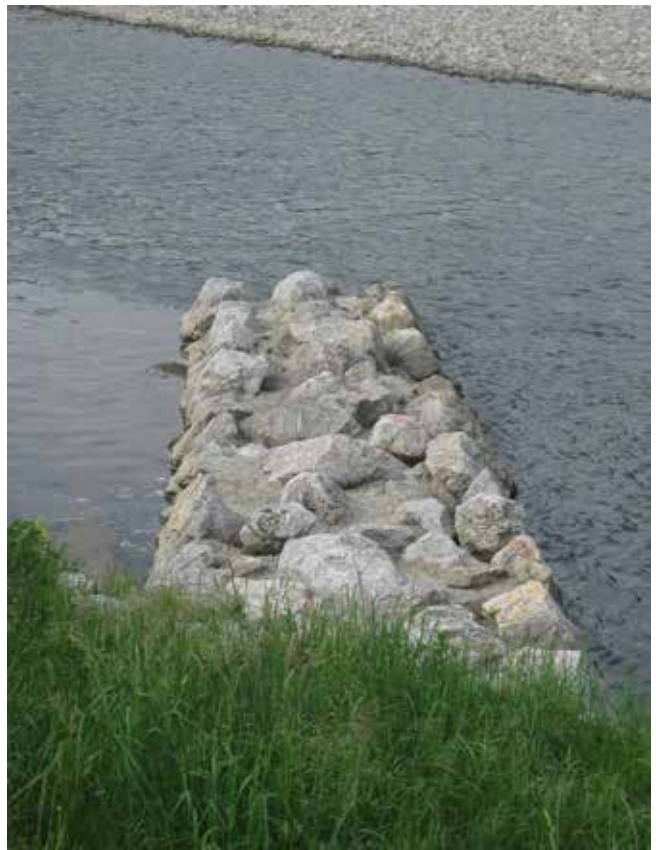
Primer jezbičice ( kamnitega odbijača ) za vzpostavljanje talne erozije in oblikovanje lokalne poglobitve – tolmana.
