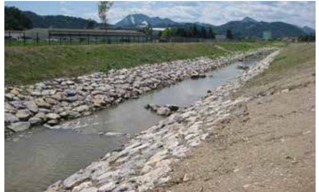
Prelivni pragovi in jezbece so poglobili korito regulacije, manjka še samo zasaditev krone z drevjem za osenčenje struge - zmanjševanje pregrevanja vode ter vetrovno zaščito pred pospešenim izhlapevanjem.
