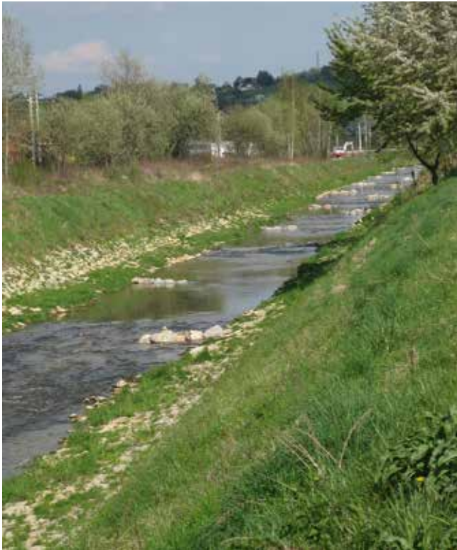
Večjo prostornino stalno omočenega korita bomo v urbanih okoljih dosegli le s pravilno vgradnjo jezbc v mehki osnovi dna.
