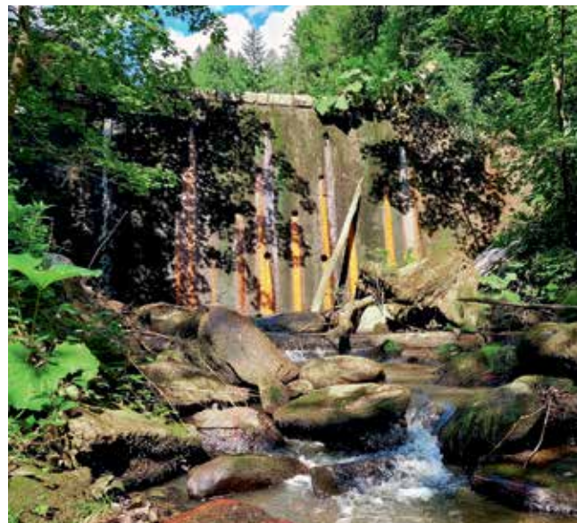
Takšni prečni objekti onemogočajo prehodnost vodnim organizmom. Foto: Jernej Košir, 2021.
