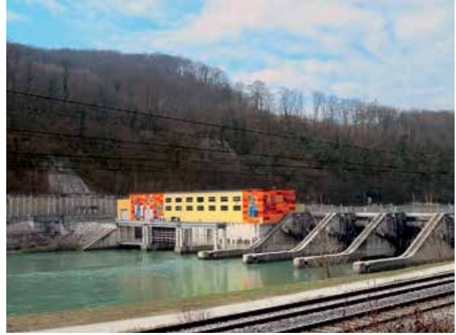
Na jezovni zgradbi hidroelektrarne se zgodba o Krškem jezeru zaključuje.
