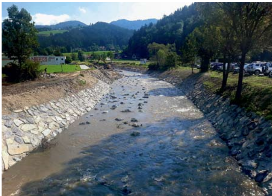
Zagotovitev poplavne varnosti industrijske cone ob reki Mislinji v Pamečah pri Slovenj Gradcu; betoniranje obeh bregov, junij 2020 (foto: Jernej Košir, 2020)
