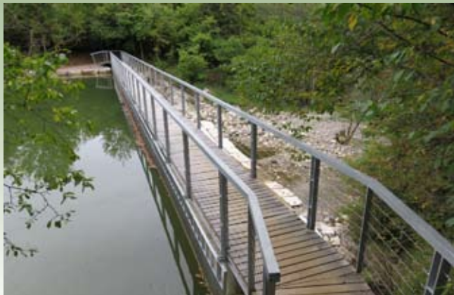
Leta 2019 so končali dela na novi betonski pregradi in po njej speljali krožno sprehajalno ter učno Orlovo pot.
