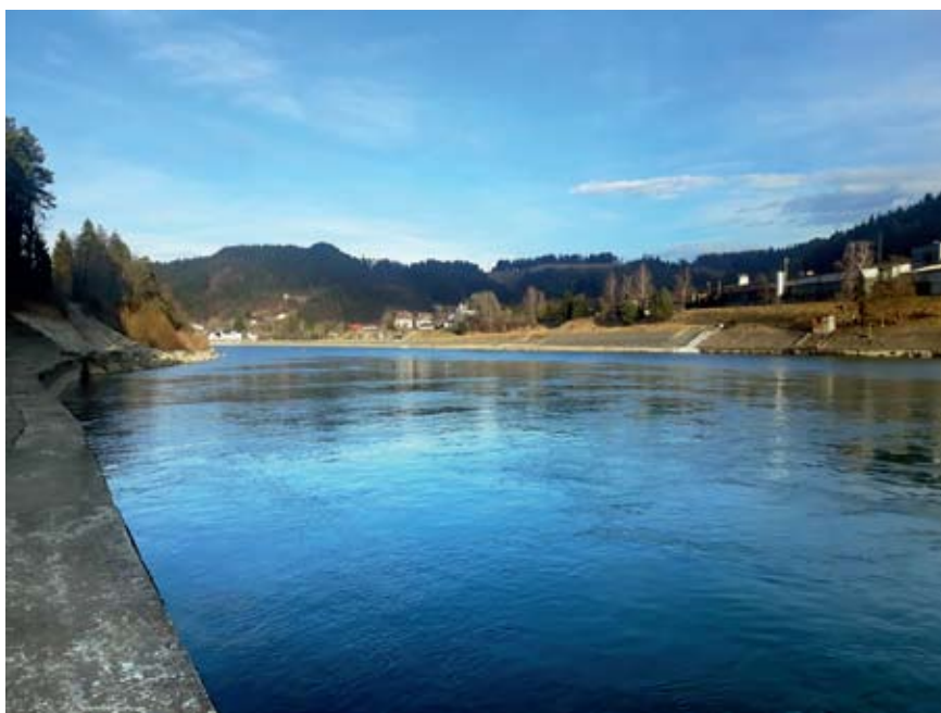
Betonsko zavarovane brežine pod HE Vuzenica (foto: Jernej Košir, 2020)
