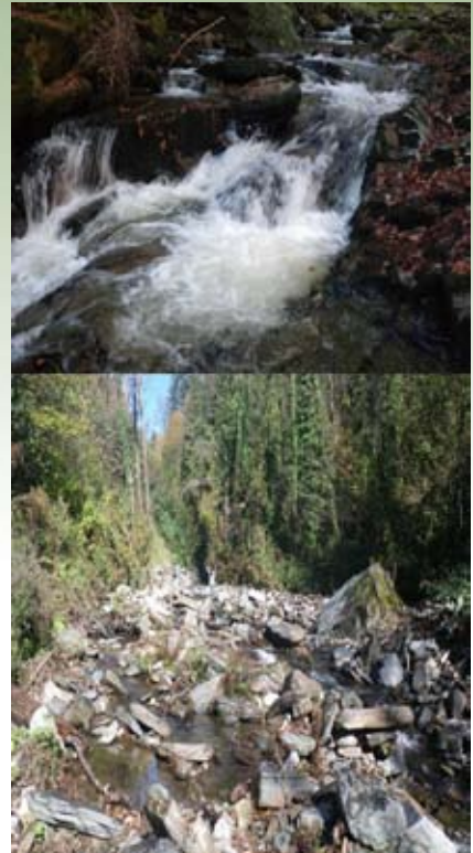
Oplotnica pred hidroelektrarno in malo pod njo (foto: arhiv Zavoda za ribištvo)
