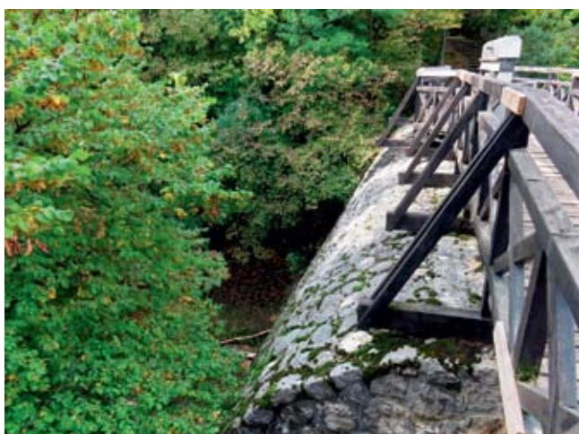
Težnostna betonsko-kamnita pregrada s sprehajalnim mostičem.
