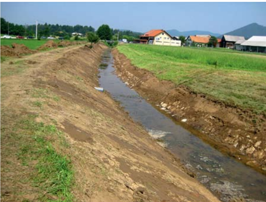
Gole krone in brežine Savinje ter njenih pritokov pospešujejo pregrevanje ter izparevanje vode do presušitve korit.
