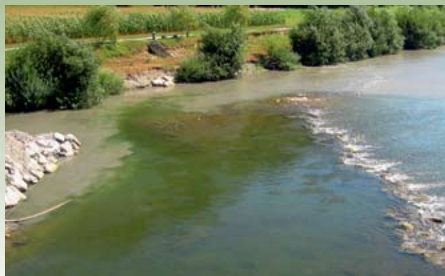
Črpanje cementnega mleka iz gradbene jame neposredno v vodotok na lokaciji drstišča v času drsti podusti
