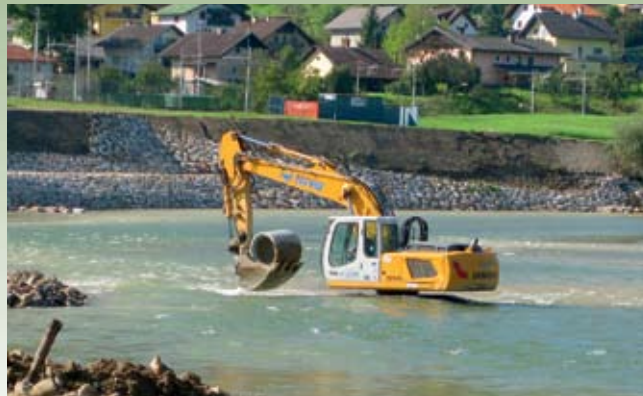
Transport gradbenih materialov po vodi
