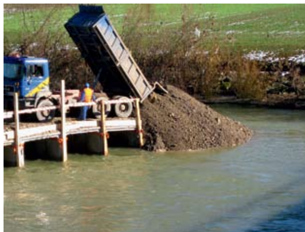
Dovažanje in vgrajevanje gramoza v gradbiščno cesto na lokaciji drstišča
