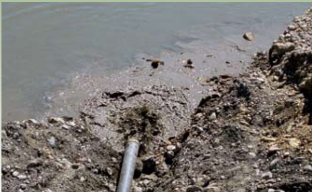
Črpanje mulja in cementnega mleka iz gradbene jame neposredno v vodotok
