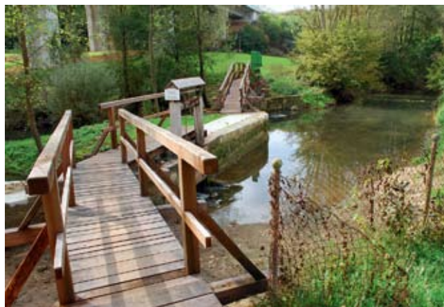
Obnovljena brv in zapornica Zakrajškovega mlina pri Ponikvah (foto: Z. Leko)
