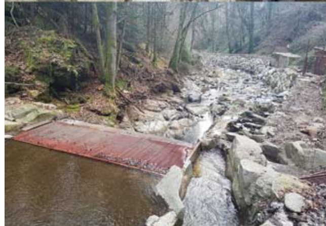
Slika 6: Neprimerno zgrajene in nedelujoče ribje steze še dodatno uničujejo vodotok. (Fotografija: Slavko Prijatelj, 2019)
