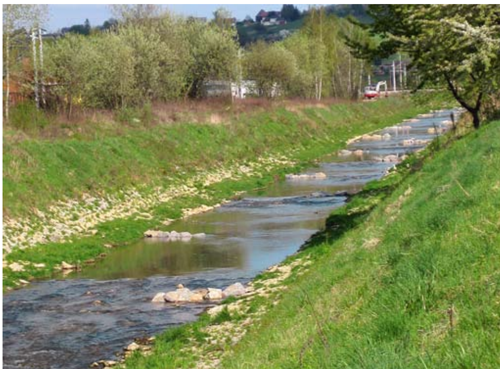
Odbijači iz lomljenca bodo med Teharjem in Zavodno poživilo dinamiko vode in povečali lokalno erozijo dna za ohranitev minimalnih življenjskih pogojev rib. Žal pa gole in z lomljencom obločene brežine »super kanala« povzročajo pregrevanje vode. Posledice necelovitosti omilitvenih ukrepov bodo vidne ob sušnih (poletnih) pretokih.
