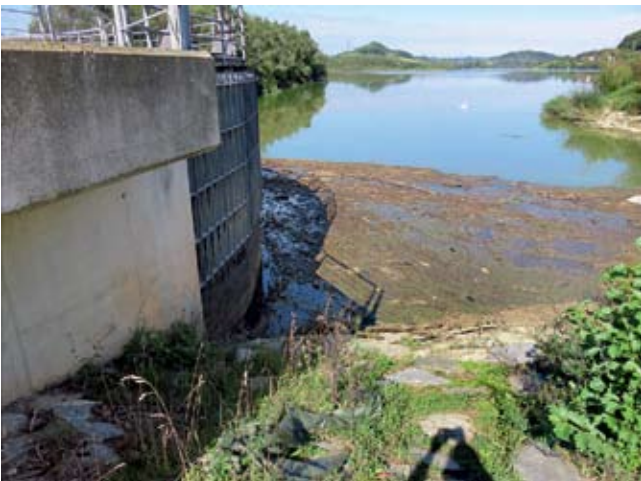
Debela plast naplavljenih organskih in komunalnih odpadkov na lovilnih grabljah iztočnega objekta temu okolju res ni v ponos.
