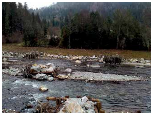
Primer primerne utrditve brežin na Savinji nad Lučami z zložbo v suho in odbijajući (foto: arhiv ZZRS).
