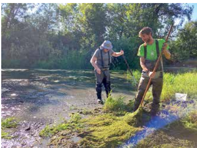
Metoda mehanskega odstranjevanja makrofitov.
