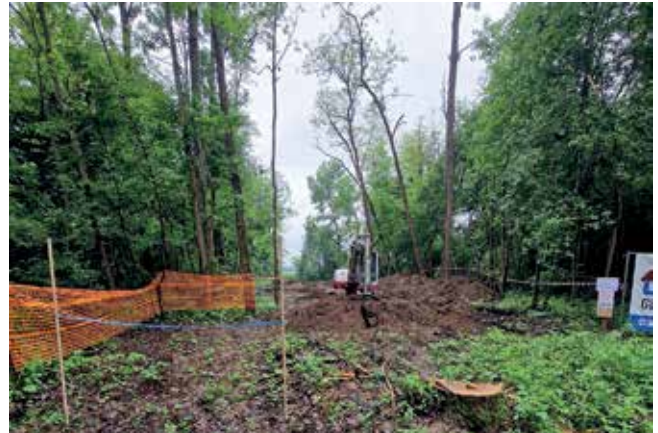
Priprava gradbišča za valilnico-ribogojnico za vzrejo kečige neposredno ob reki Muri v Črncih, občina Apače.
