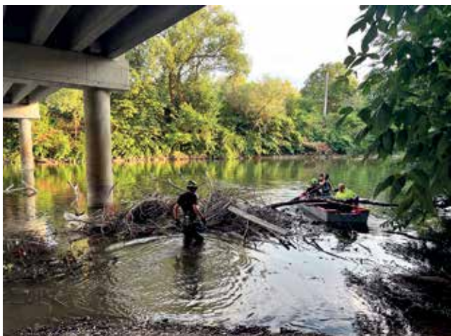
Odstranjevanje naplavin pri mostovih
